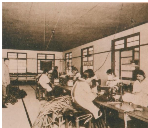
図 1-28 猿江裏町不良住宅地区改良事業中の住吉授産場（ゴザ工場） 22
